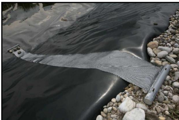
Photo 17 : Echappatoire installé sur un bassin
