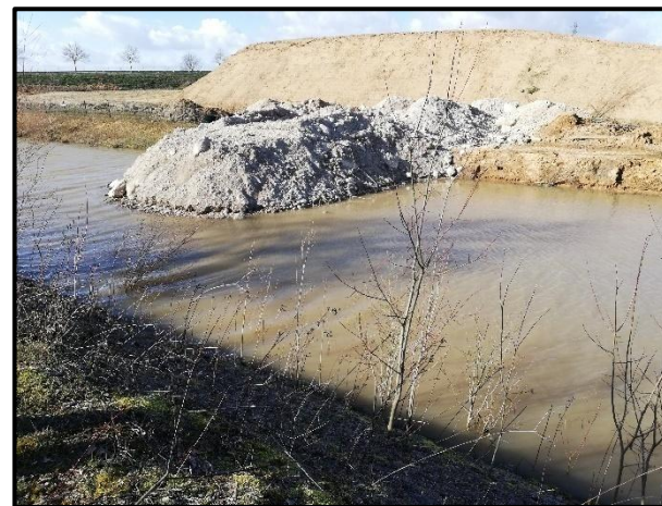
Photo 12 : Avancée de déblais au sein du bassin (Rainette, 2019)
