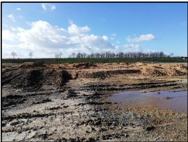
Photo 14: Zone de chantier en perpétuel changement (Rainette, 2019)
